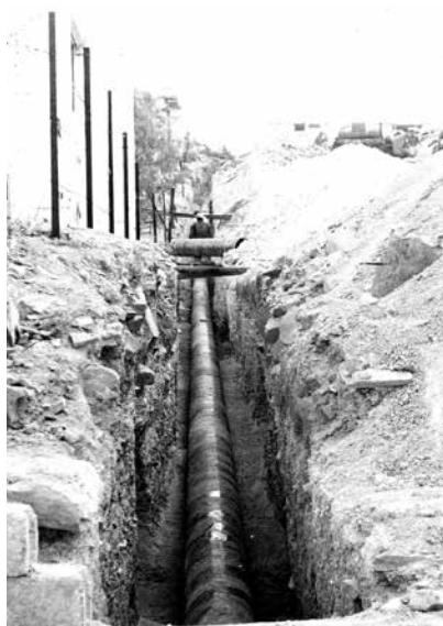
La introducción de la tubería de drenaje continuó sin parar por diferentes rumbos de Monclova y Frontera.
