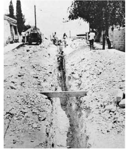
Los trabajos del drenaje continuaron por las colonias de la periferia.
