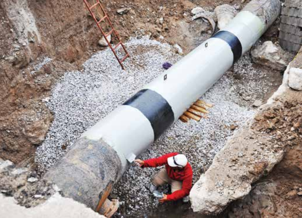
La reposición de tuberías ha permitido cubrir la demanda de agua potable de Monclova y Frontera.
