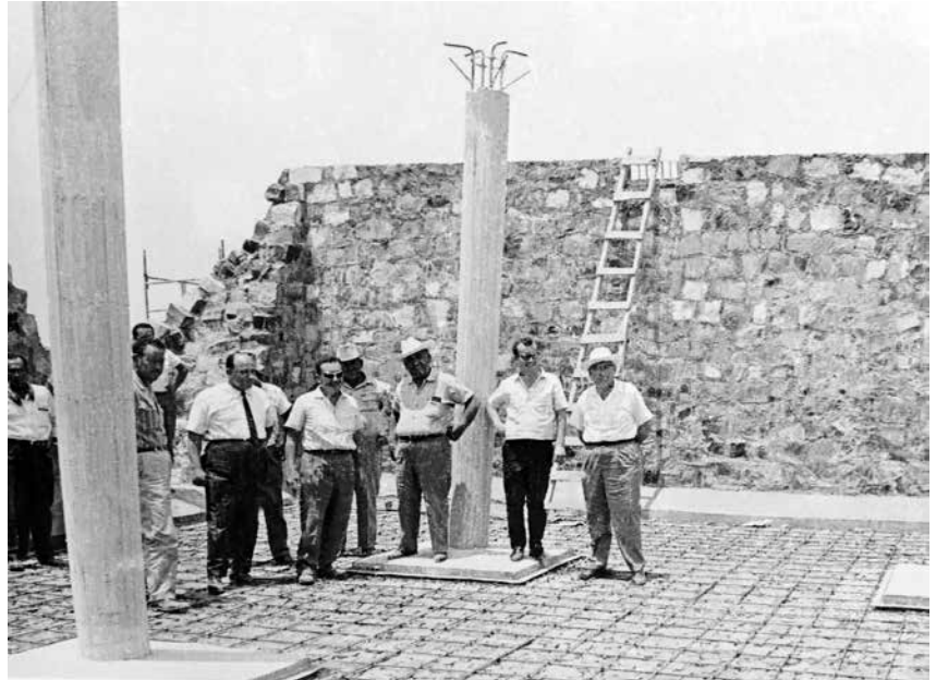
Para cubrir la demanda de agua se construyó un segundo tanque de almacenamiento en La Ermita.
