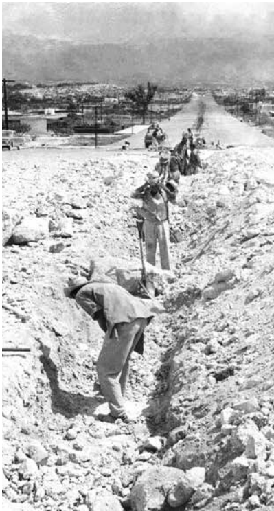
Trabajos de la excavación para la introducción de la tubería de agua potable para Monclova.
