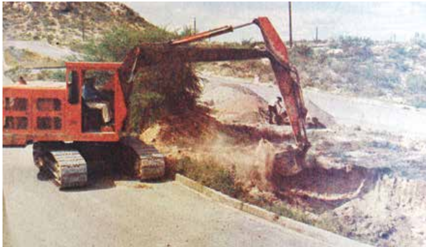
Introducción del drenaje en la colonia Guadalupe.
