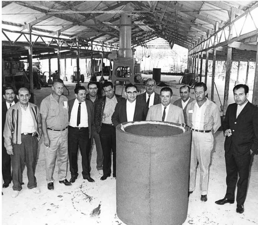
El alcalde José González Ballesteros inauguró la fábrica de tubos para el drenaje, acompañado por Guillermo Williamson Haro, Arturo Villarreal, Edmundo Aguilar, Enrique Castillo, Armando Flores Peña y Santiago Prince, entre otros.
