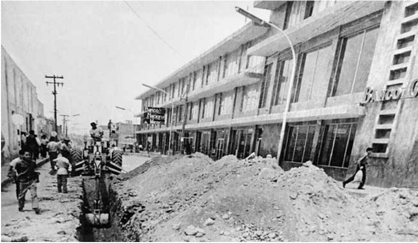
Introducción del drenaje en las calles V. Carranza y Zaragoza.
