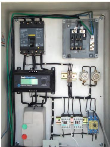
En la zona de captación pozuelos ( Nuestra zona de captación más importante), se realizaron inversiones en modernización del tendido eléctrico y la estandarización de 13.2 a 34.5 kva en nuestra red, esto además de la modernización de los tableros de control de motores permitieron reducir en un 80% las fallas de continuidad de la energía eléctrica.
